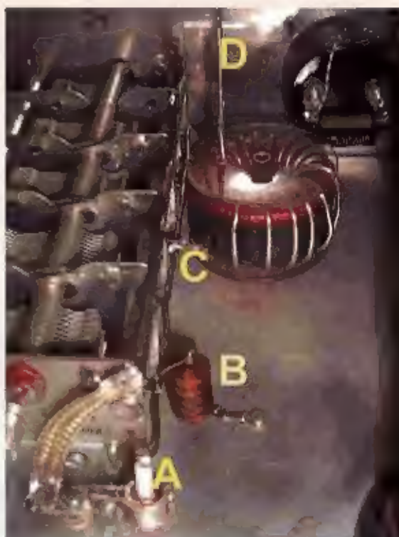
Foto 4 - Plaatsing van de 160-meter spoel en de binnenkomende coax-kabel.
